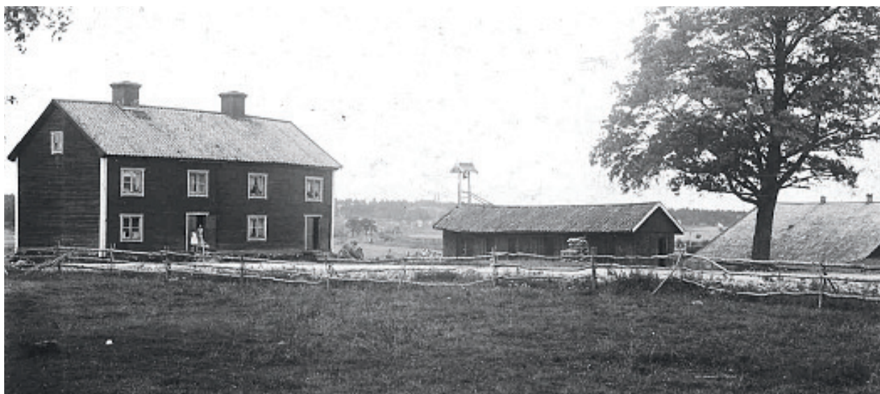
Statarebyggnaden med tillhörande vedbodar. I bakgrunden till höger ser man taket på ladugården.
